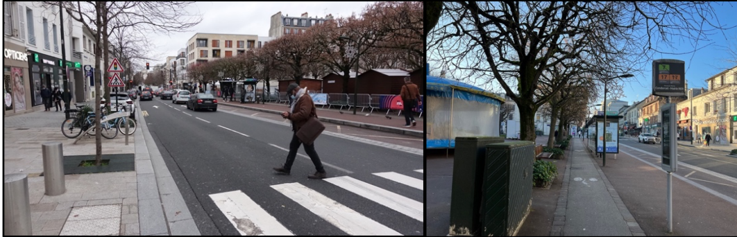
Trottoir ouest et RD 920 avec ses 2 voies montantes
